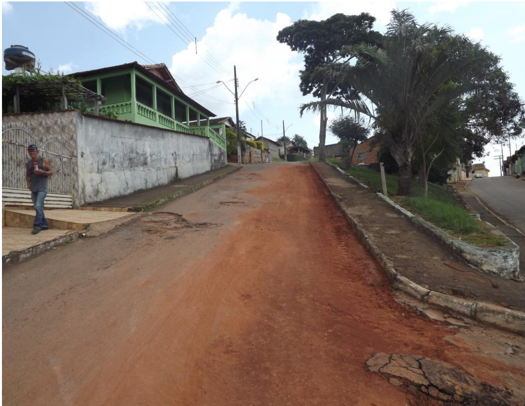
FOTOGRAFIA 04- RUA MANOEL RAMOS
