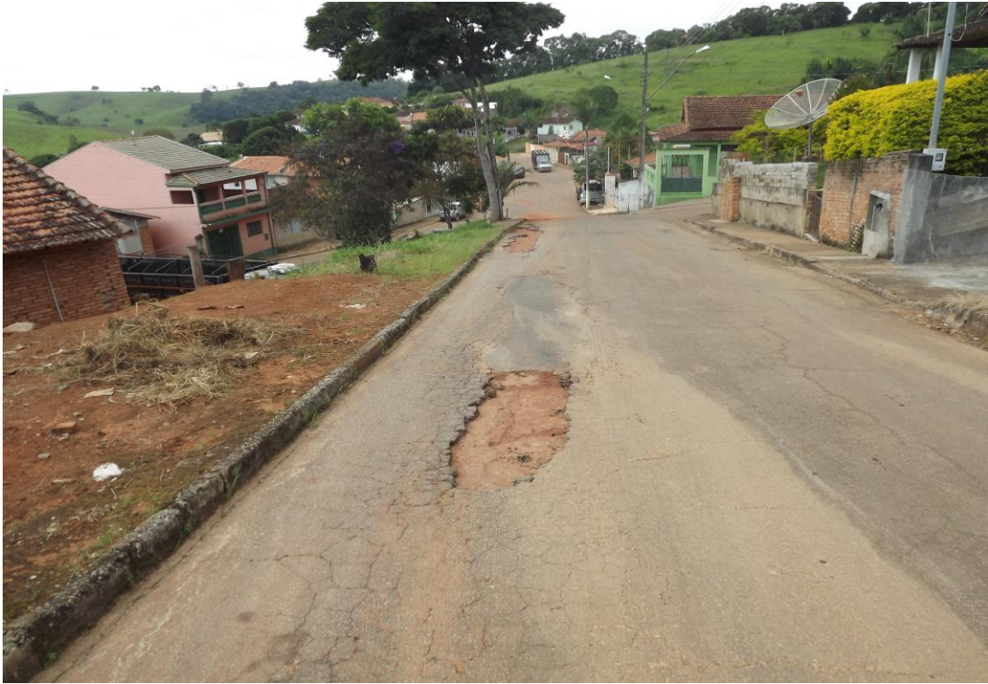
FOTOGRAFIA 05- RUA MANOEL RAMOS
