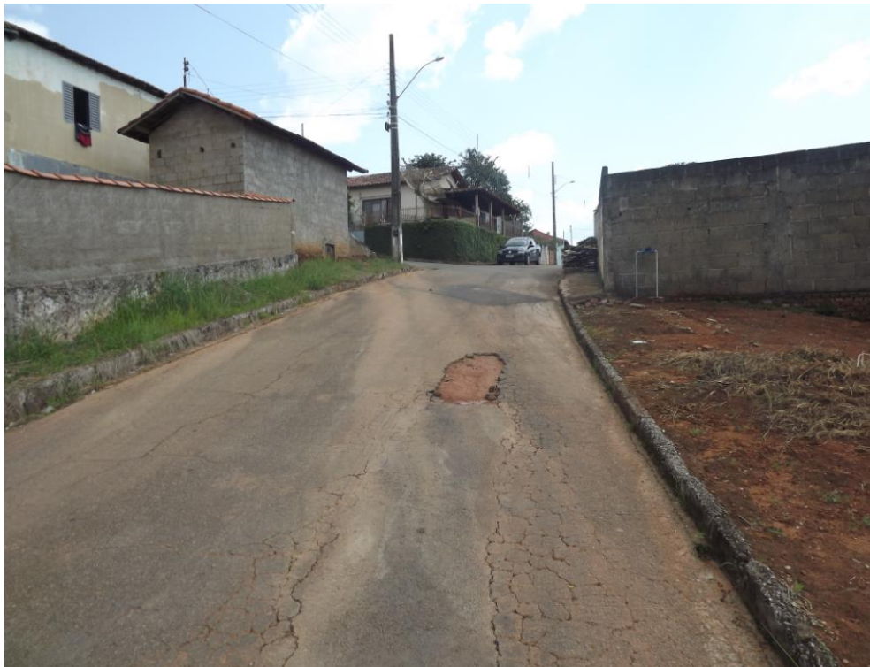
FOTOGRAFIA 06- RUA MANOEL RAMOS
